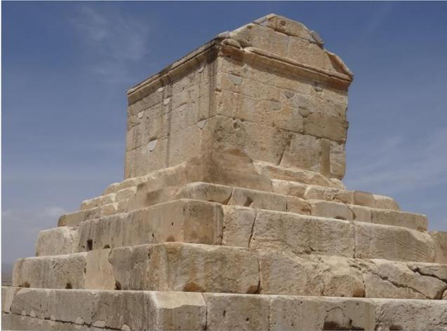
Le mausolée est édifié sur un podium à degrés. L'ensemble est construit en blocs de grande taille, appareillés à joints vifs. Les pierres de l'édifice étaient assemblées par des goujons de plomb, selon une technique inconnue jusqu'alors et empruntée aux architectes de Lydie.
